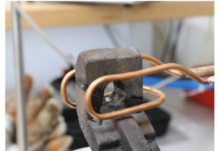
Beim Hartlöten wird die gesamte Fläche der Bruchstelle mit Silberlot benetzt. Nicht nur die Aussenkante wie beim schweißen, sondern die gesamte Bruchstelle wird dadurch verbunden. Die Verarbeitungstemperatur beim Löten liegt weit unter der des Schweißens und verändert die Eigenschaften des Werkstoffes nicht. Die Verbindung bleibt zäh und kann Spannungen aufnehmen. Es entsteht eine saubere und bei entsprechender Nachbehandlung praktisch unsichtbare Naht.
